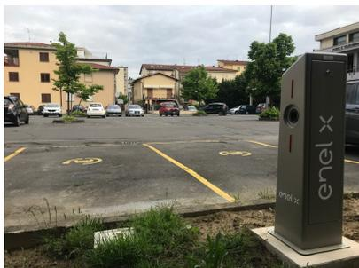
Le infrastrutture di ricarica sono di tipo quick da 44 kW (due punti di ricarica da 22 kW per ogni postazione) e consentono ai **veicoli elettrici**, che potranno usufruire di posti auto dedicati in prossimità di ogni colonnina, di effettuare una ricarica in modo "intelligente" e "interoperabile". L'interoperabilità è particolarmente importante perché il possessore del mezzo elettrico può effettuare la ricarica indipendentemente dalla società di vendita con cui ha stipulato il contratto.
