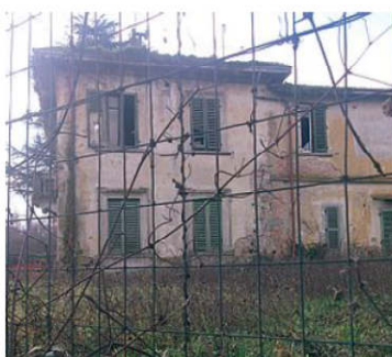
Un cantiere trasennato da tempo (senza che nessuno vi lavori) all'ingresso di Incisa
